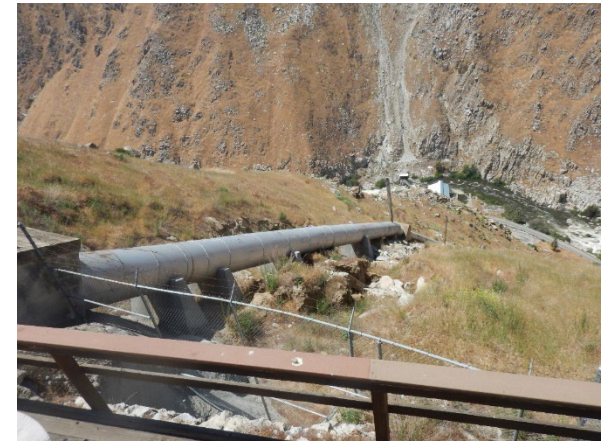
Forebay Spillway Pipe
